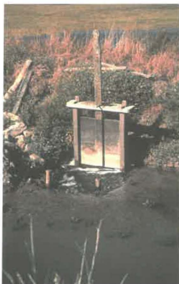
Fig. 12. Lavori primaverili, rifare il cavedino (sopra).
